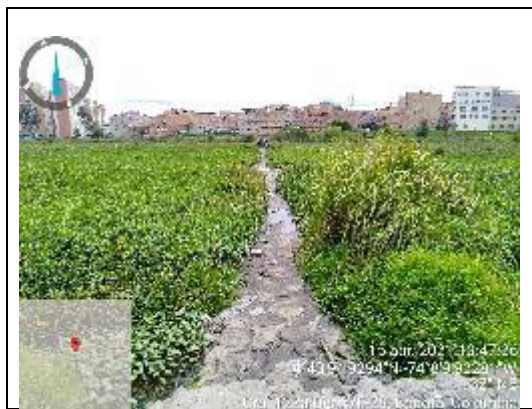
Figura 78 Estructura de control 15/04/2021
