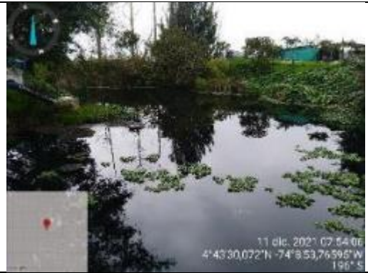
Figura 5 Este vertimiento del cual se presume corresponde a conexión errada que viene del canal Maranta es REITERATIVO se enviará memorando 2021E291385 a la SRHS. Registro del 11/12/2021
