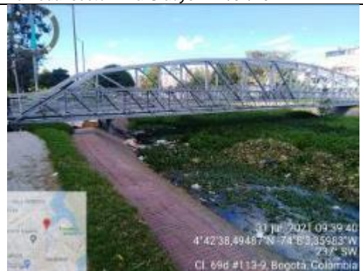
Figura 25 Presencia de residuos sólidos en franja acuática Borde sur tercio alto sector Marandú – 31/07/2021
