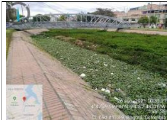
Figura 58 Buchón en canal perimetral borde sur brazo del humedal sector Marandú – 26/08/2021
