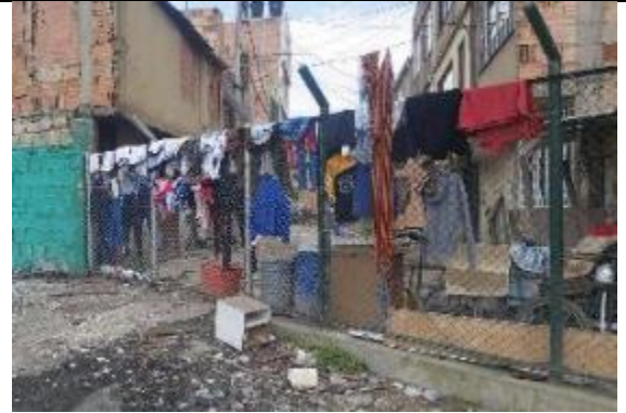
Figura 193 Zona 4. Borde Norte Tercio alto: UNIR II hasta estructura de control. Malla eslabonada instalada. 19/11/2021
