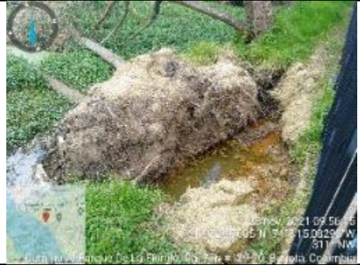
Figura 382 Zona 5. Borde Norte Tercio medio: UNIR II desde estructura de control hasta límite de jarillón los eucaliptos con ciclo ruta
