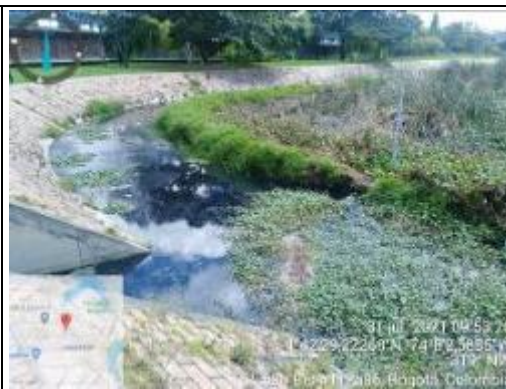
Figura 19 Box coulvert Borde sur tercio alto sector Ebenezer parte posterior IED Tomas Cipriano De Mosquera
