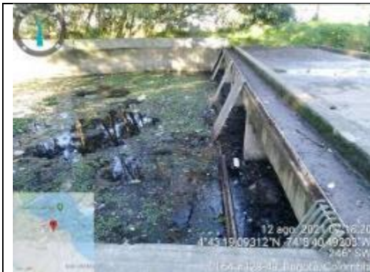
Figura 28 Colmatación por residuos en canal Maranta -12/08/2021
