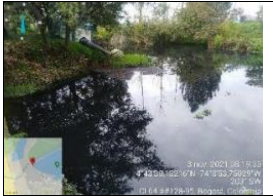
Figura 4 Vertimiento y/o conexión errada en canal Marantá (foto sector barandas amarillas).- 03/11/2021
