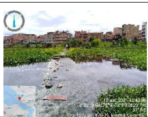
Figura 79 Estructura de control 15/04/2021
