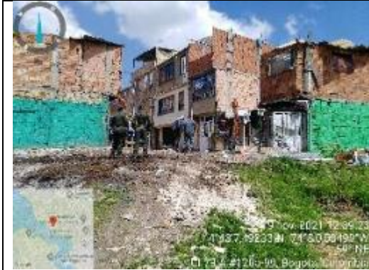
Figura 192 Zona 4. Borde Norte Tercio alto: UNIR II hasta estructura de control. La malla eslabonada que protegía y delimitaba el humedal fue hurtada, volviendo este lugar en un punto crítico por disposición clandestina de RCD's y que requiere intervención para restauración ecológica. El 19/11/2021 se realizó retiro de RCD's, explanación del terreno e instalación de nueva malla eslabonada.
