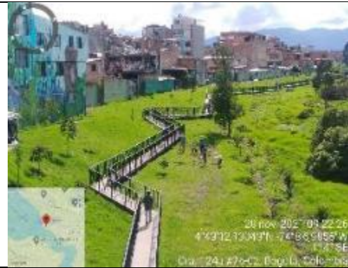
Figura 386 Zona 4. Borde Norte Tercio alto: UNIR II hasta estructura de control
