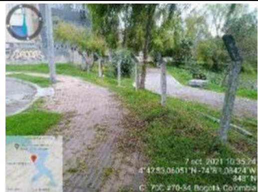
Figura 197 Zona 4. Borde Sur Tercio alto: Conjunto Engativá centro hasta conjunto Senderos de Engativá sector específico volteadero. Cerramiento instalado 07/10/2021
