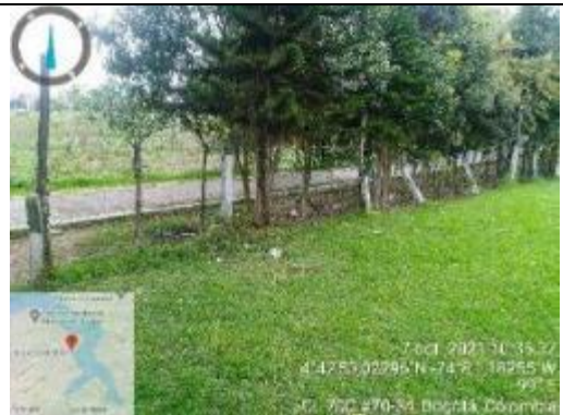
Figura 195 Zona 4. Borde Sur Tercio alto: Conjunto Engativá centro hasta conjunto Senderos de Engativá sector específico volteadero. Cerramiento instalado 07/10/2021
