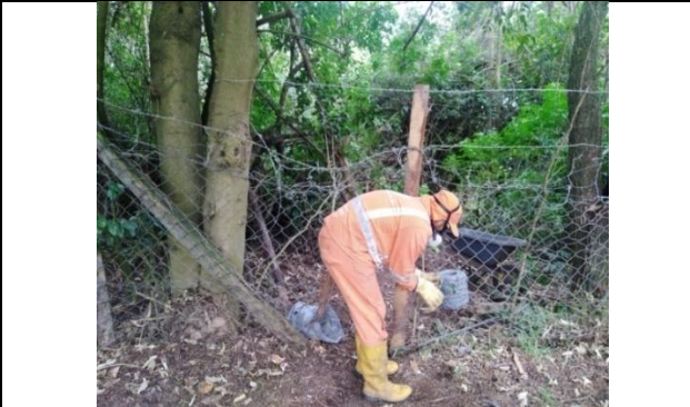
Fotografía 91 Personal de aguas Bogota - Franja acuatica realizando mantenimiento al cerramiento
