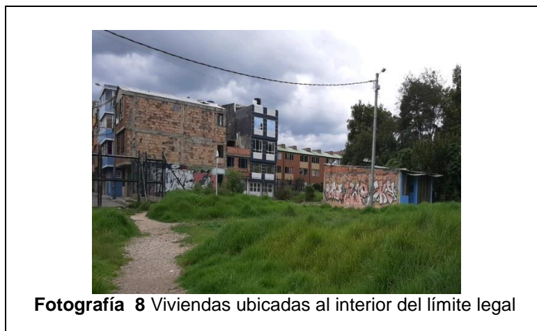
Fuente: Grupo Humedales SDA- 2021
