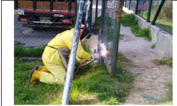
Fotografía 90 Personal de aguas Bogota - Franja acuatica realizando mantenimiento al cerramiento
