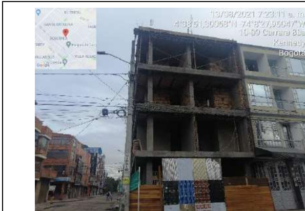
Fotografía 10 Nuevas ampliaciones en el PEDH Techo
