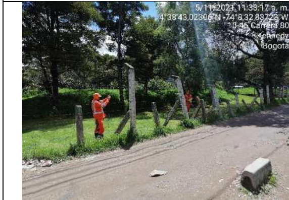
Arreglo del cerramiento provisional en el sector 1 del PEDHTE.
