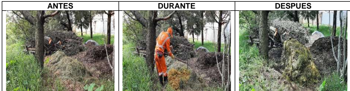
Volteo de pilas de compostaje.
