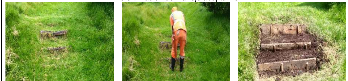
Instalación y mantenimiento de escalinatas
