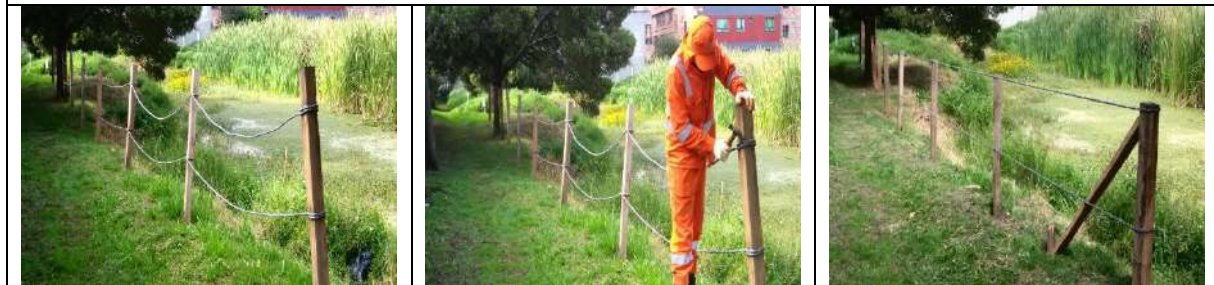
Instalación y mantenimiento de barandas
