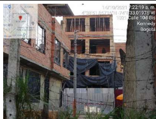
Fotografía 17 Nuevas ampliaciones en el PEDH Techo
