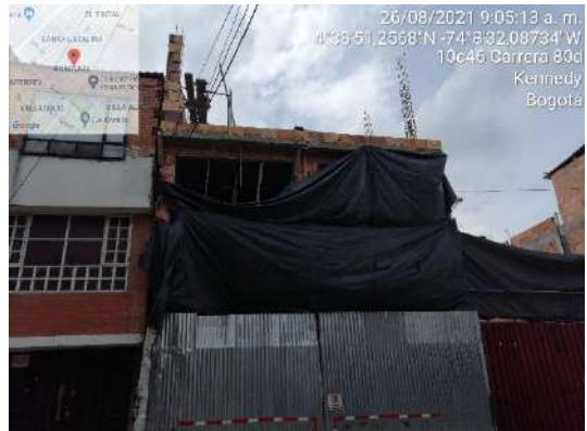
Fotografía 15 Nuevas ampliaciones en el PEDH Techo
