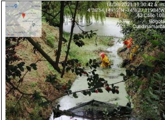
Apertura de espejo de agua, sector 2 PEDHTE
