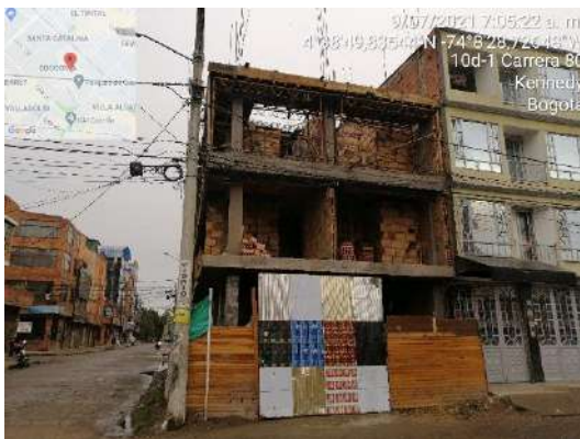
Fotografía 8 Nuevas ampliaciones en el PEDH Techo
