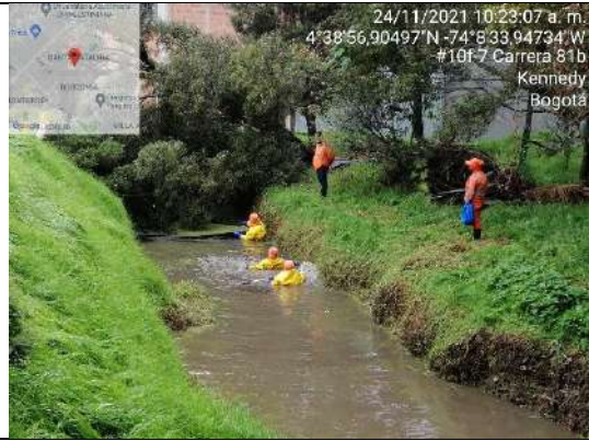
Apertura de espejo de agua en el sector 2 del PEDHTE.
