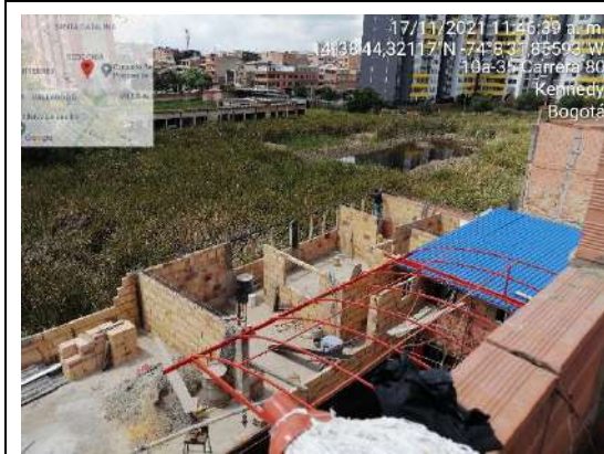
Fotografía 16 Nuevas ampliaciones en el PEDH Techo
