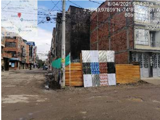
Fotografía 4 Nuevas construcciones en el PEDH Techo
