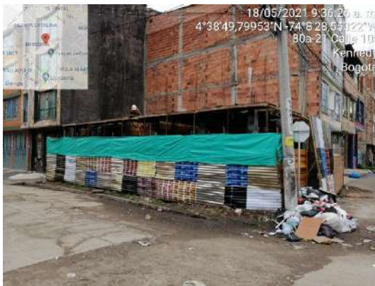
Fotografía 6 Nuevas ampliaciones en el PEDH Techo
