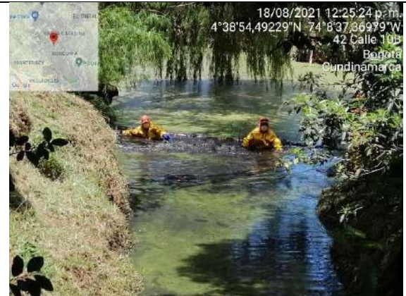
Apertura de espejo de agua, sector 2 PEDHTE
