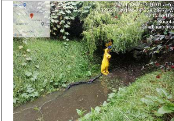
Poda de formación de sauce sobre el canal perimetral del sector 2 PEDHTE.
