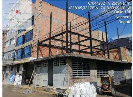
Fotografía 5 Nuevas construcciones en el PEDH Techo
