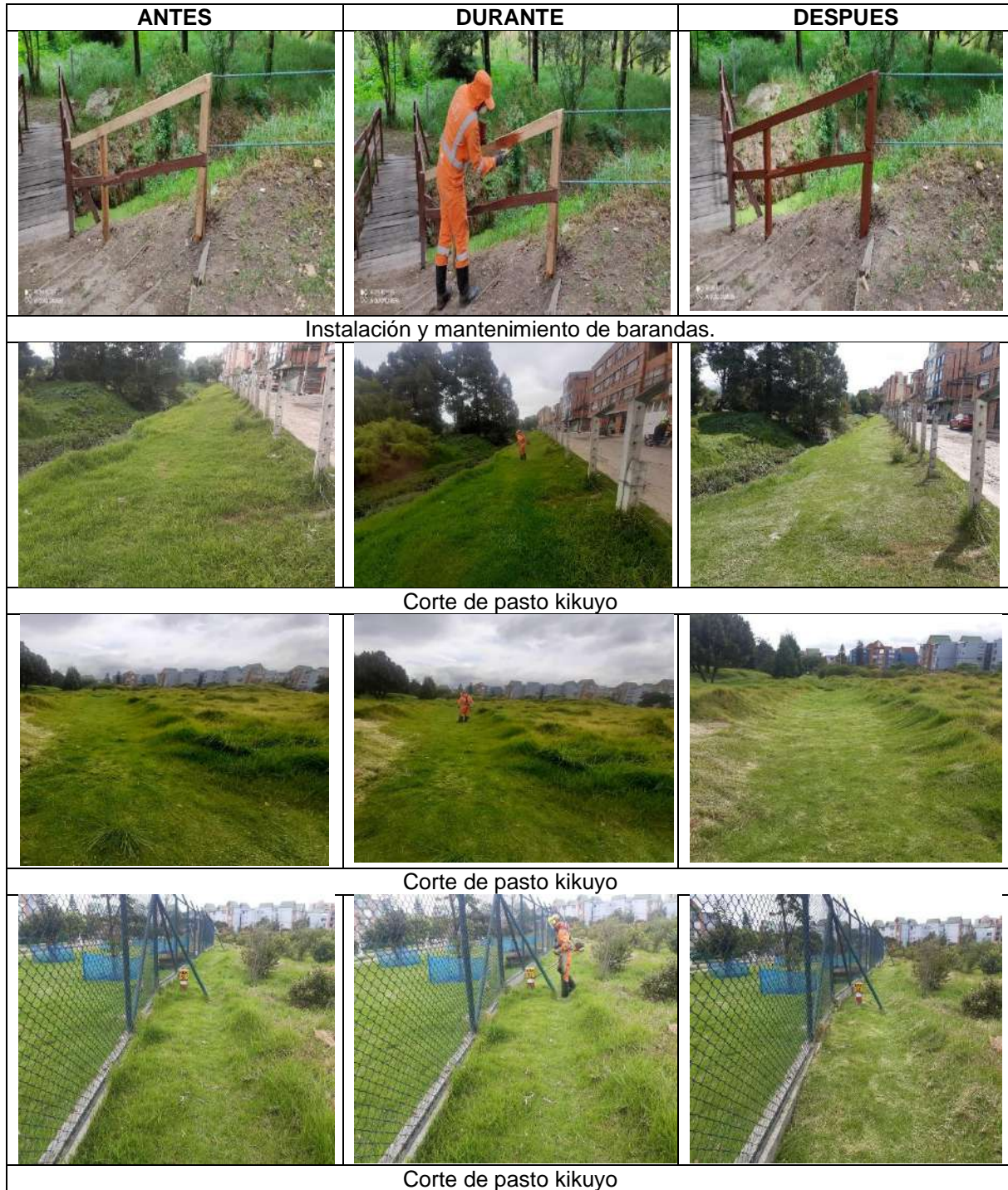
Fotografía 65 Mantenimiento mes de septiembre sector 1 y 2
