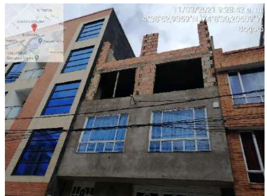
Fotografía 9 Nuevas ampliaciones en el PEDH Techo
