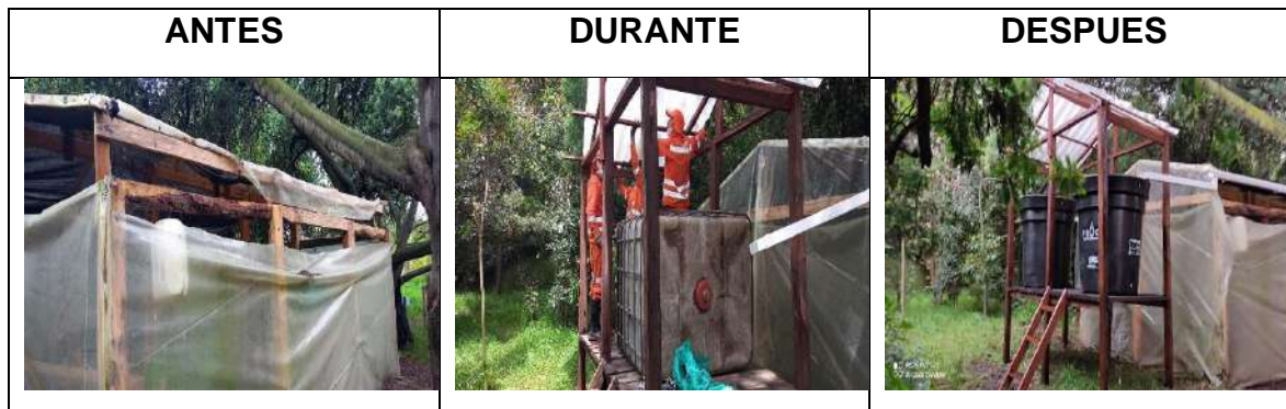
Fotografía 68 Finalización instalación cosechadora de aguas lluvias
