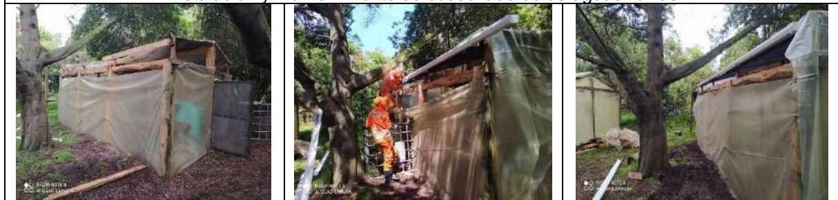
Instalación y mantenimiento de cosechadoras de aguas lluvias
