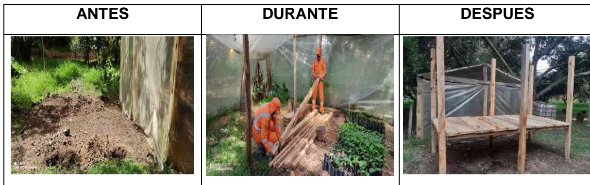
Fotografía 67 Inicio de instalación cosechadora de aguas lluvia
