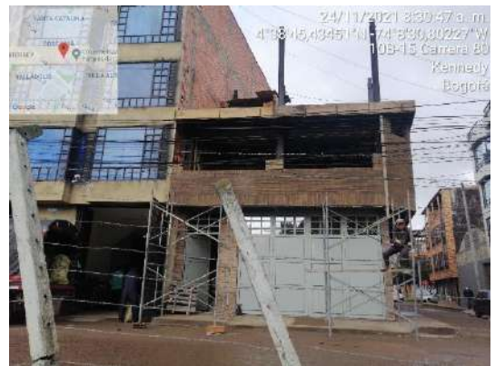
Fotografía 7 Nuevas ampliaciones en el PEDH Techo
