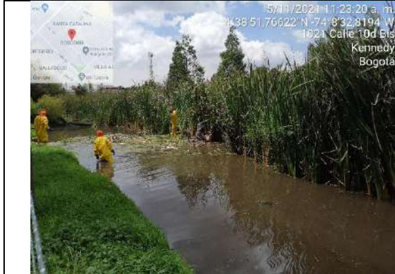
Apertura de espejo de agua sector 1.1 del PEDHTE.
