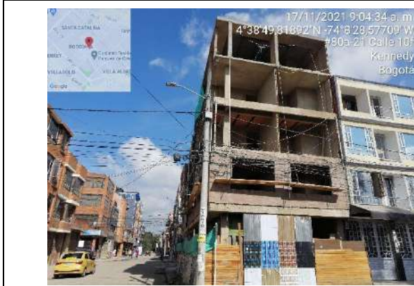
Fotografía 12 Nuevas ampliaciones en el PEDH Techo
