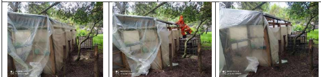
Instalación y mantenimiento de cosechadoras de aguas lluvias
