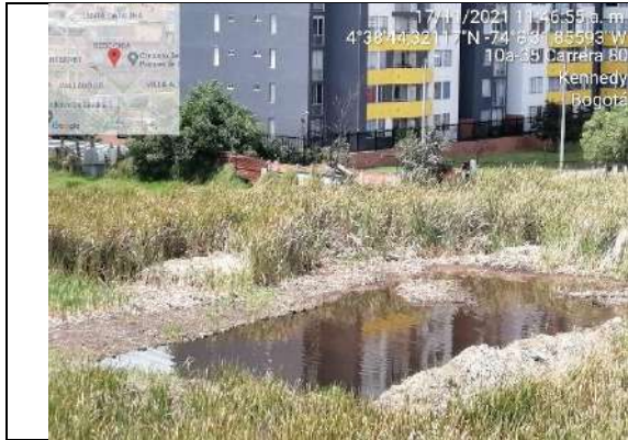
Apertura de espejo de agua en el sector 1.1 del PEDHTE.
