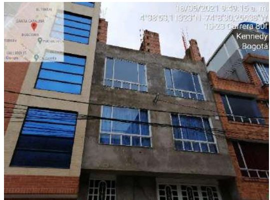
Fotografía 11 Nuevas ampliaciones en el PEDH Techo
