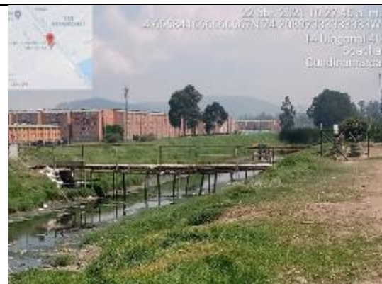
Fotografía 22. Paso irregular fuera del límite del Humedal.
