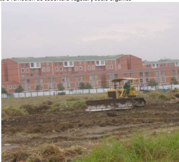
Foto 6. Descapote o remoción de cobertura vegetal y suelo orgánico
