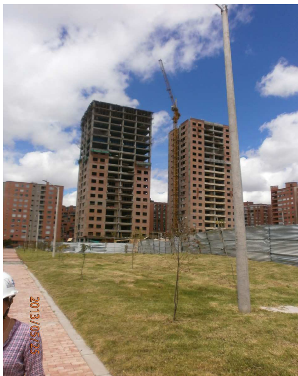
Foto 4. Cerramiento del frente de obra hacia espacio público
