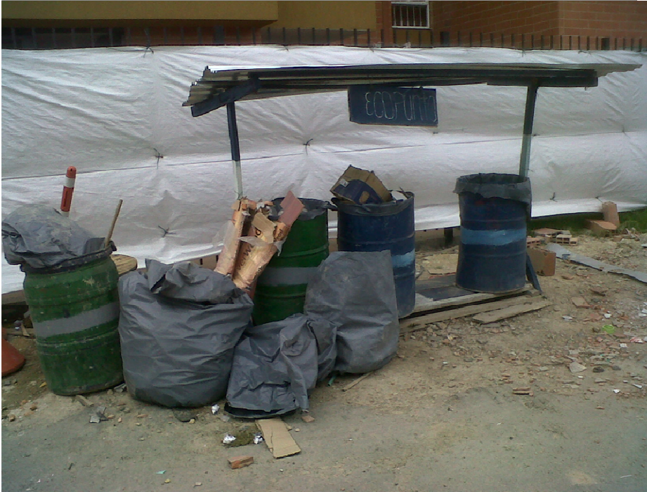
Foto 45. Práctica inadecuada: sitio de separación de RCD sin condiciones técnicas
