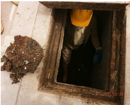
Foto 13. Limpieza de sumideros
