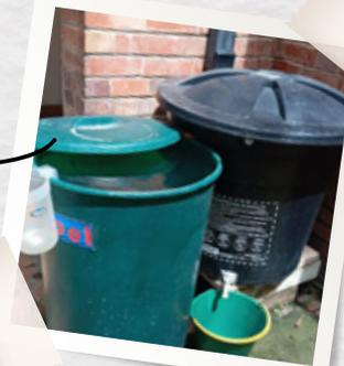
Imagen 4. Sistema captación aguas lluvias.
