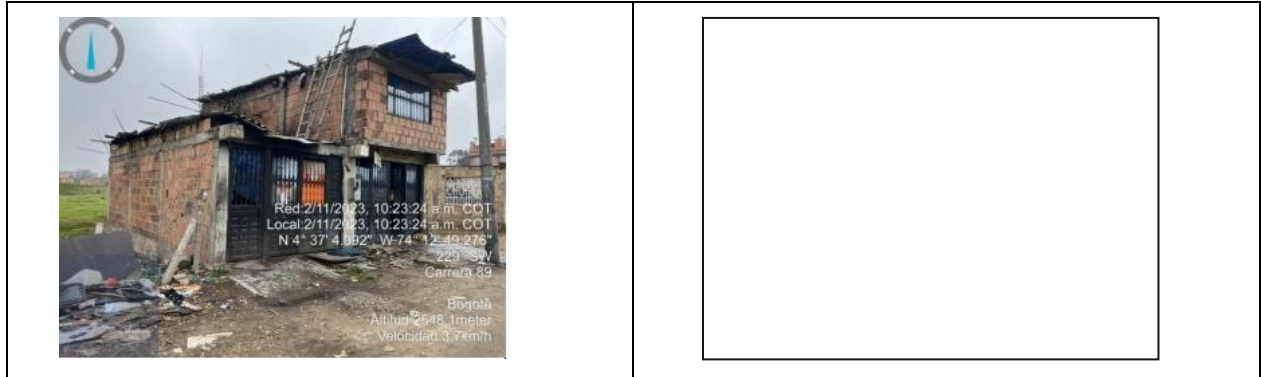
Fotografía 58: Evidencia vivienda de invasión sector biofiltro
