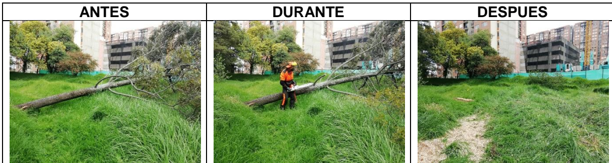
Despeje de arbol caido en sendero interpretativo del sector 2 del PEDHTE.
